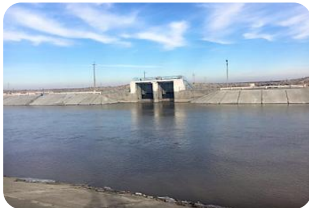
[ 부스탄 관개 수로 확장 후 ]
